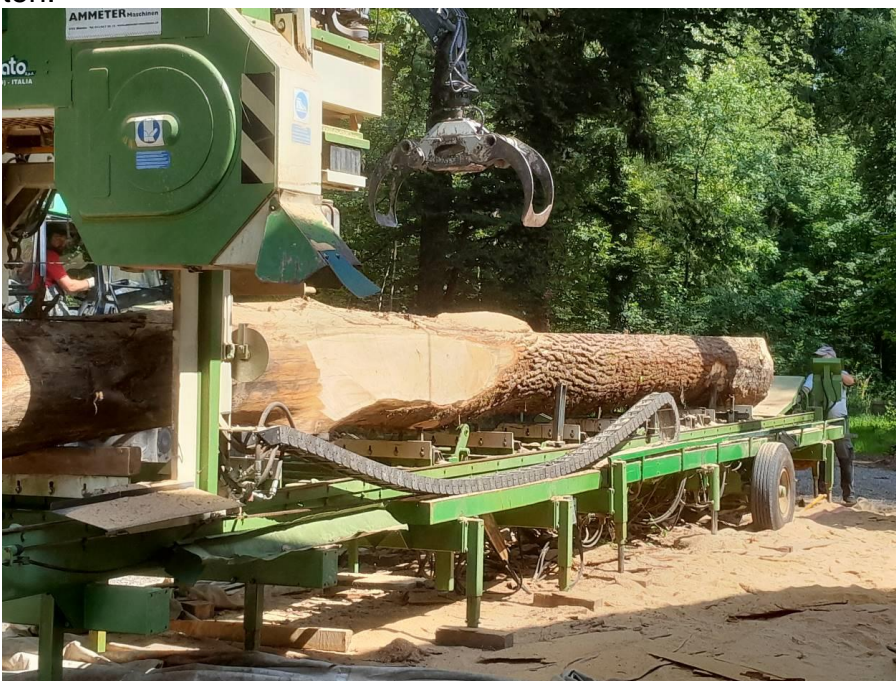
Eine mobile Säge im Einsatz beim Schneiden von eichigen Trägerbalken für eine Fussgängerbrücke.
